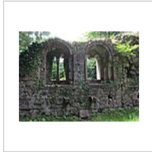
Romanische Fenster, ehemals Ostwall des Saalbaus (heute in Ottrott)
