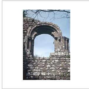
Romanisches Fenster, Südwall des Saalbaus
