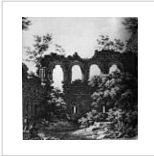
Saalbau 1815, Südwall mit Fensterarkade
