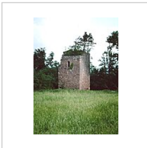
Westlicher Bergfried („Hungerturm“)
